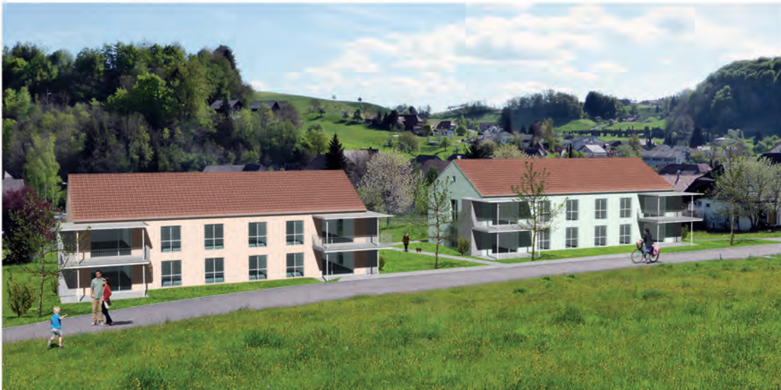
Neubau Mehrfamilienhäuser am Rosenweg, 4917 Melchnau Bauherrschaft: Genossenschaft zur Erstellung preiswerter Wohnungen Aarwangen
