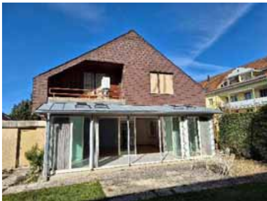
Südfassade mit Wintergarten und Balkon
