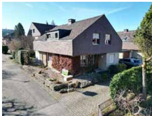
Nordostfassade mit Hauseingang und Zufahrt
